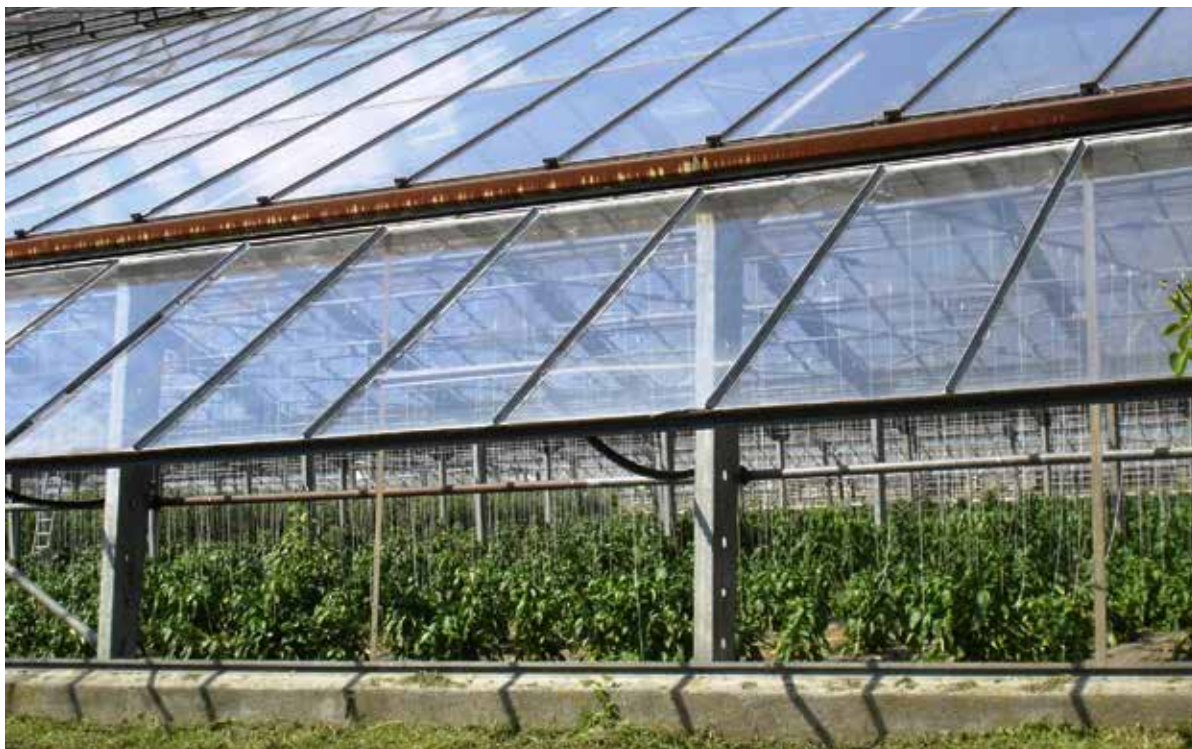
Nelle aziende Bio Gemma il riscaldamento invernale delle serre sottostà a diverse limitazioni. Fotografie: Elia Stampanoni
